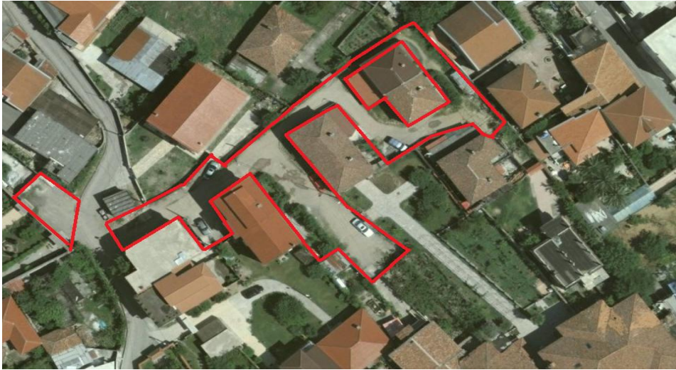
Foto evidentuese - shpjeguese të gjendjes aktuale të rrugës
