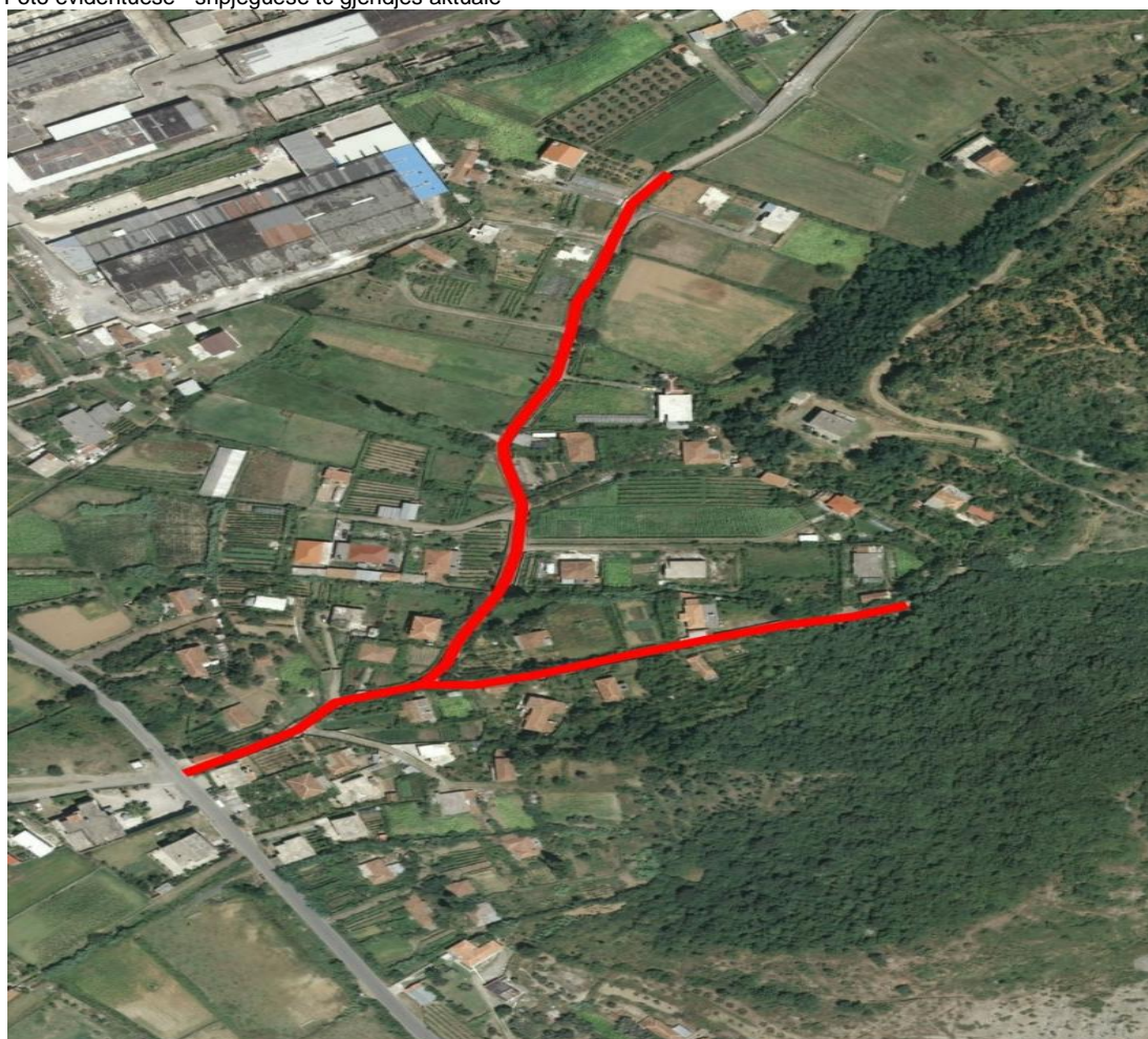
Foto evidentuese - shpjeguese të gjendjes aktuale
