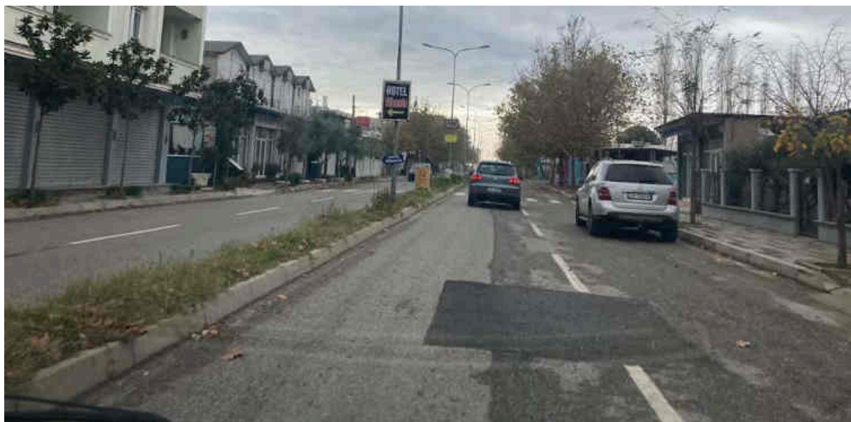
Figure 3.21: Foto të rrugëve të ndryshme në Velipojë
