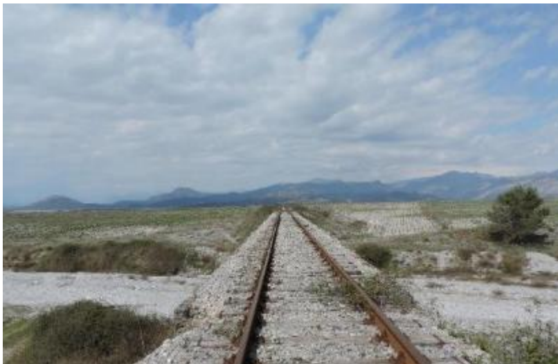
Figura 85:Pamje J-V. Perroi i Thate; Toka bujqesore permes nenzones se perdorimit tradicional; Km 127+100; Hekurudha kalon 1.4 km ne perendim te kufirit lindor te RMN dhe 3.5 km nga bregu i liqenit te Shkodres
