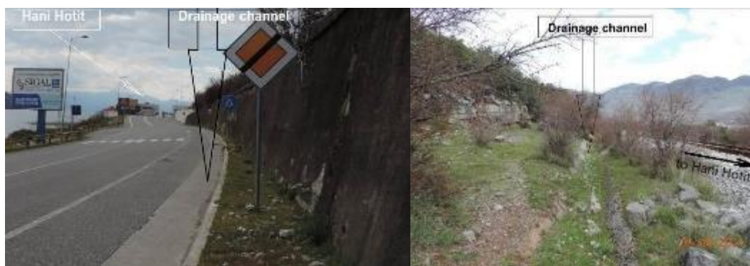
Figura 74: Hekurudha nga km 139 në 140; Majtas: Kanal kullues në të majte të hekurudhës; Djathtas: Kanal kullues në të djathtë të hekurudhës
