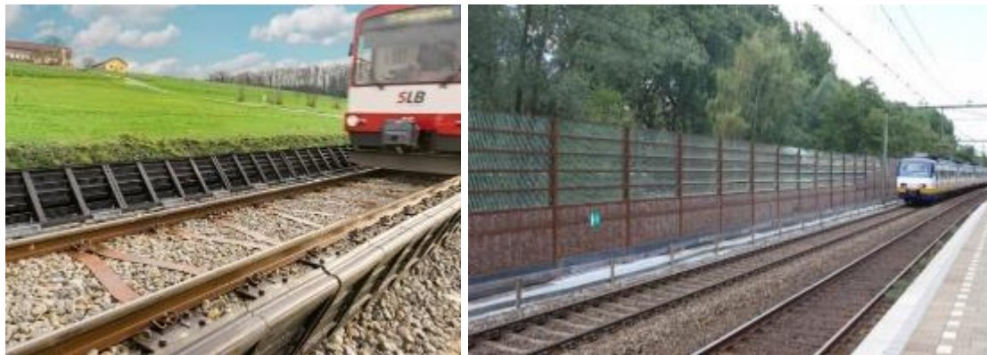
Figura 100Majtas: Barriera e ulët dhe absorbuese e zhurmës; Djathtas: Lloji i përzier i barrierave të zhurmës 42
