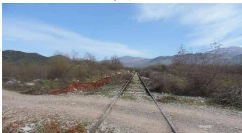
Figura 90: Kalesa ne nivel ne fshtin Skac (km 133+370); Pamje J-V;
