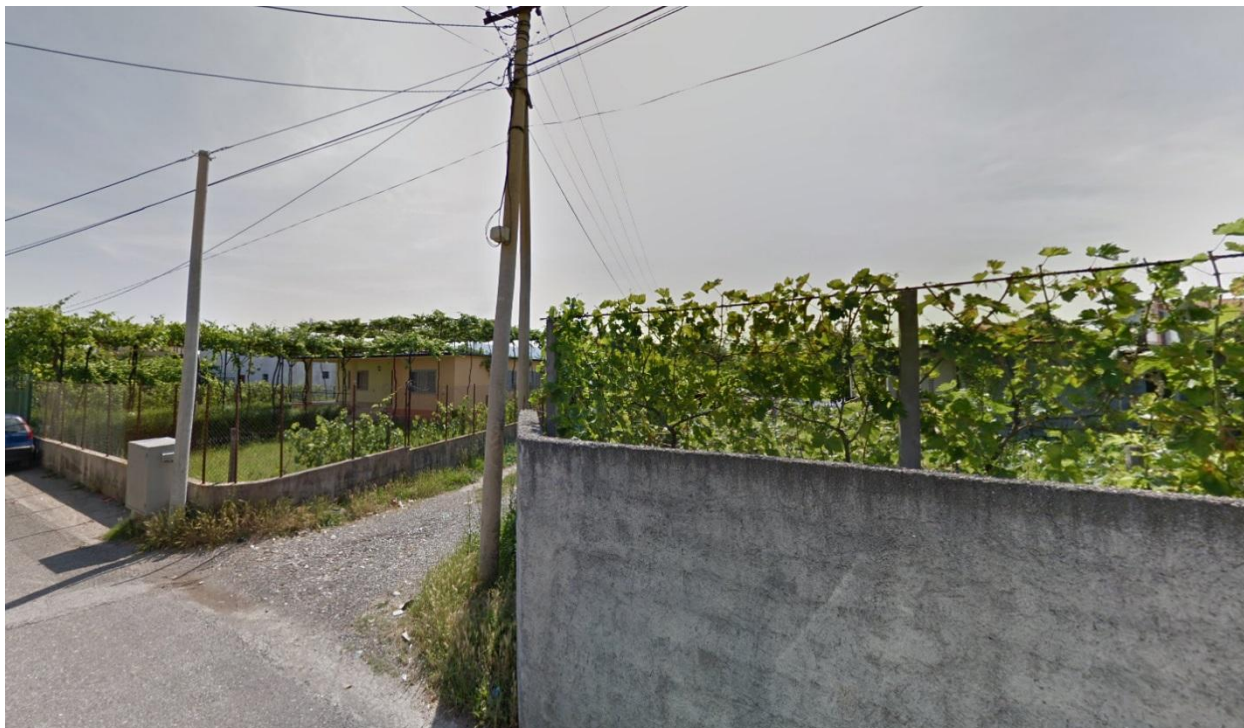
Foto evidentuese - shpjeguese të gjendjes aktuale të rrugës
