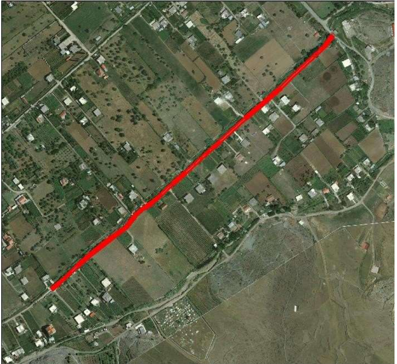
Foto evidentuese - shpjeguese të gjëndjes aktuale të rrugës
