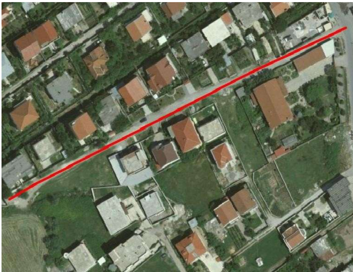
Foto evidentuese - shpjeguese të gjendjes aktuale
