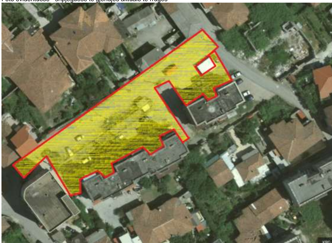
Foto evidentuese - shpjeguese të gjendjes aktuale të rrugës
