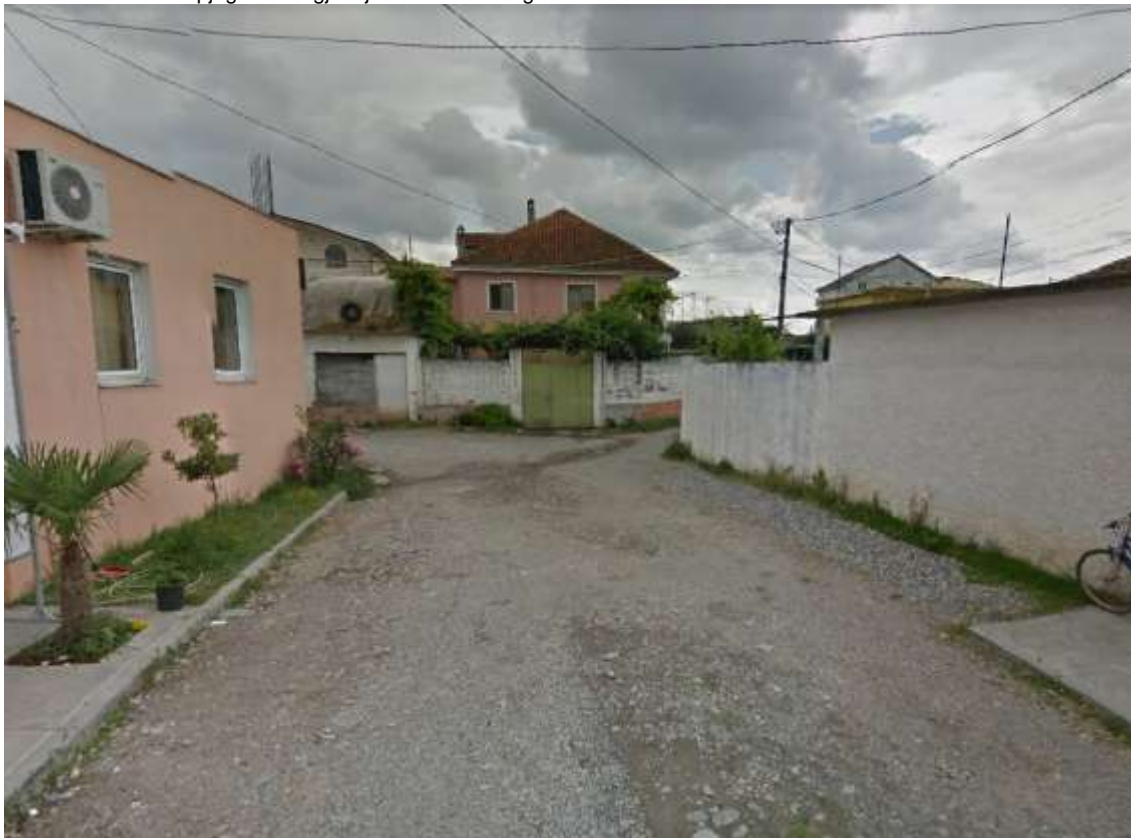
Foto evidencuese-shpjeguese të gjendjes aktuale të rrugës
